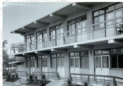
C 鉄筋コンクリート造2階建ての部室棟。1階は定時制の部室でした。
