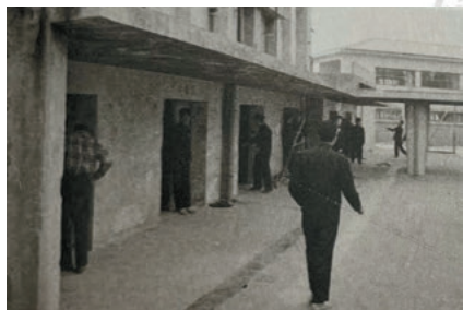
D 昭和P型校舎にあった、半地下のような部室群。最も長い間存在した部室でしたが、昭和校舎の建替えとともに姿を消しました。
