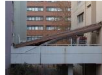
連絡通路の屋根崩落
