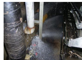
配管の破損による水漏れ
