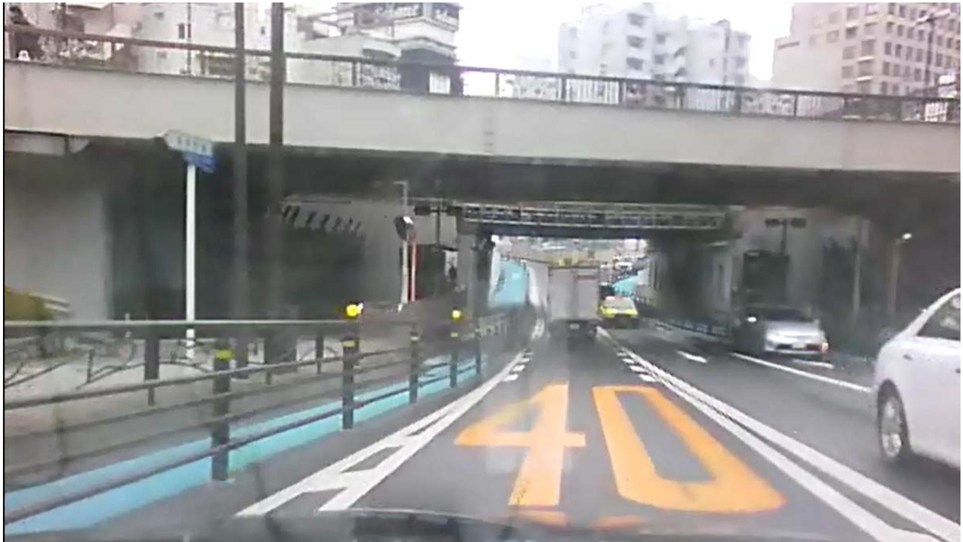
府中街道下りJR線川崎駅高架橋アンダーパス 歩行者、自転車(専用一方通行)、自動車の通行区分明示
