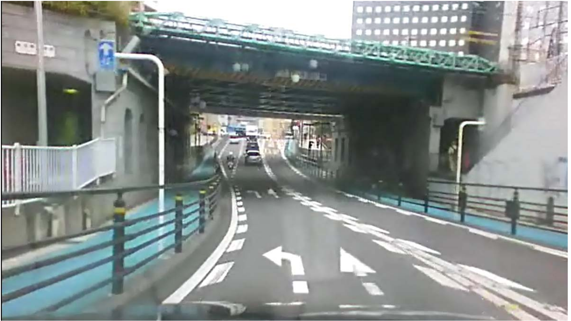
府中街道上り JR線川崎駅高架橋アンダーパス： 歩行者、自転車(専用一方通行)、自動車の通行区分明示
