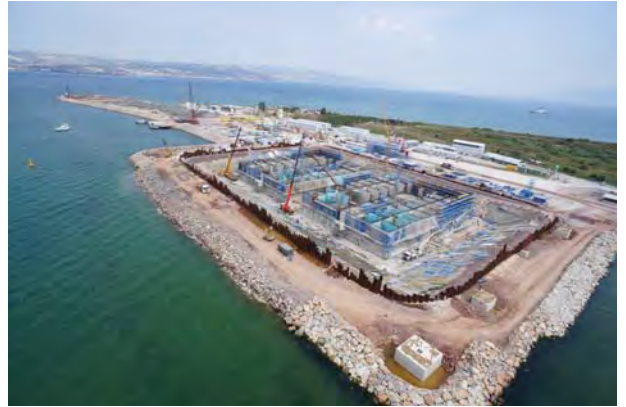
南側Site全景(2013年7月26日時点)
