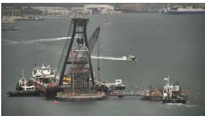
Anchor Frame Installation (2014年4月30日)
