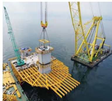
主塔下部の架設(1~11段目) フローティングクレーンによるブロック架設
