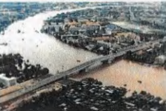
ターチャン橋 バンコク 73 住友建設最初の海外工事
